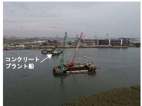
コンクリートプラント船による打設状況
