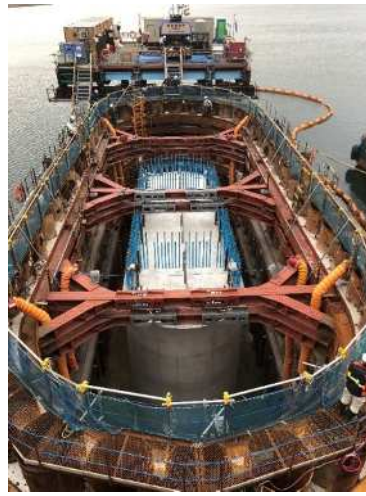
P4橋脚施工状況
