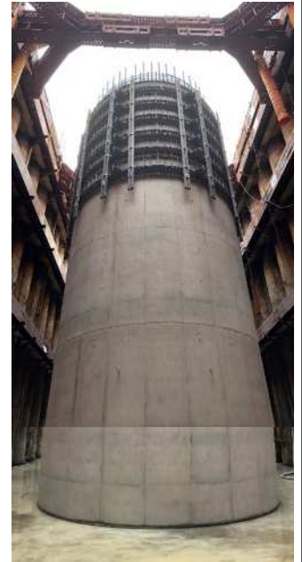
P4橋脚施工状況 (頂版から撮影)
