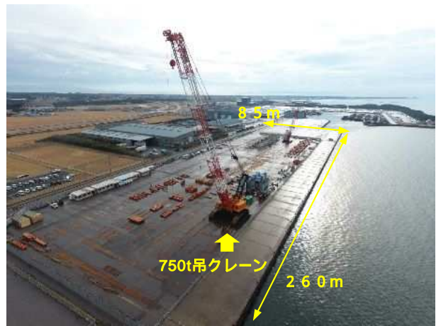
富津港地組ヤード全景
