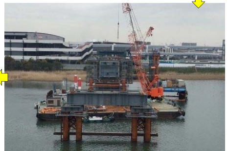
B3ベント設置完了
