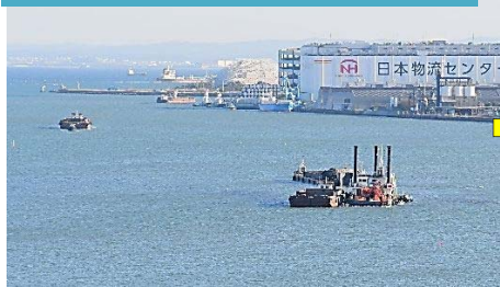
浚渫状況 (航路部)
