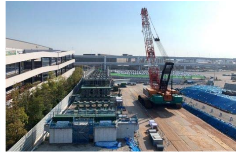
送出し架設ヤード全景 （B1バントから望む）
