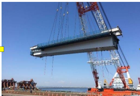
橋桁吊り上げ状況 (千葉県富津市)
