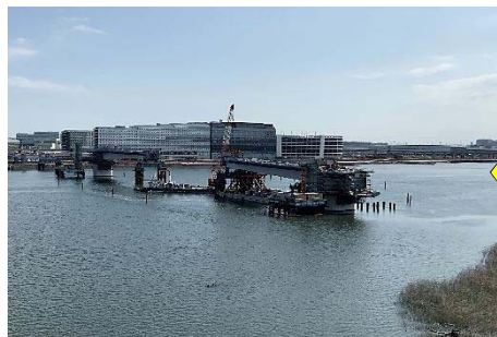
台船架設完了
