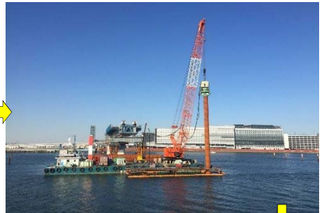
B3ベント基礎杭打設状況
