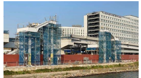
桁架設完了
