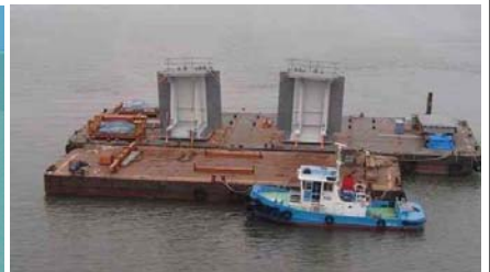
写真1 鋼桁ブロック運搬状況
