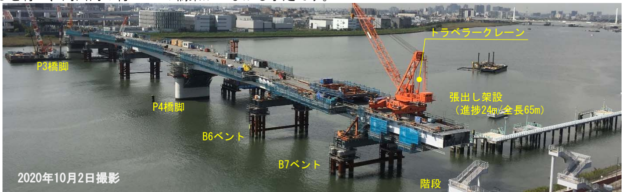
張出し架設状況 (羽田側⑧)
