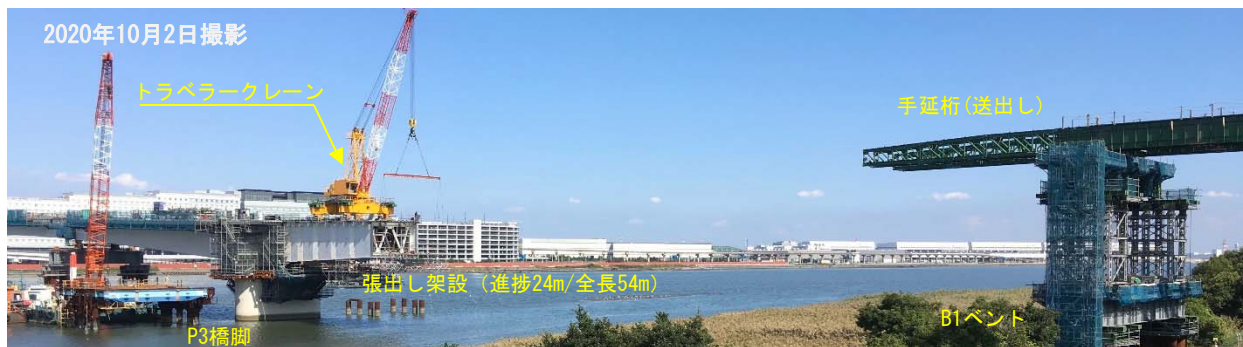
張出し架設状況 (川崎側⑨)
