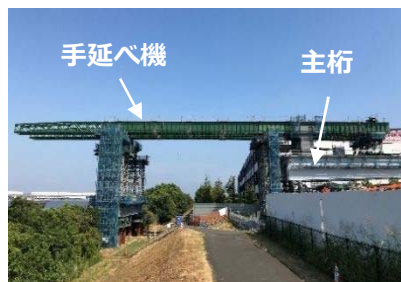
図2 手延べ機と送出し主桁
