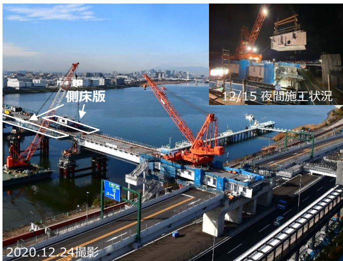
羽田側⑧張出し架設完了全景
