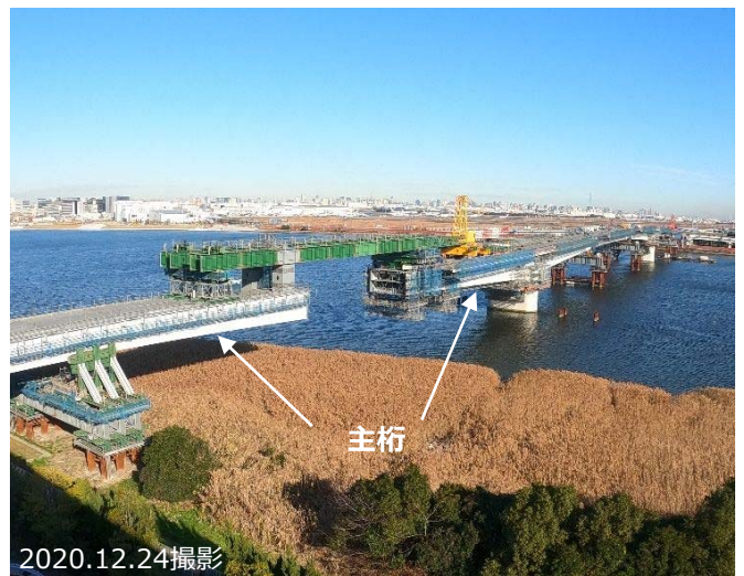
川崎側⑩送出し架設状況
