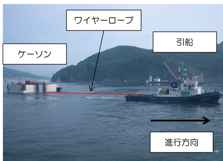
ケーソン海上運搬状況
