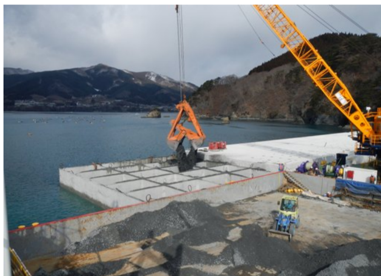
中詰材投入状況
