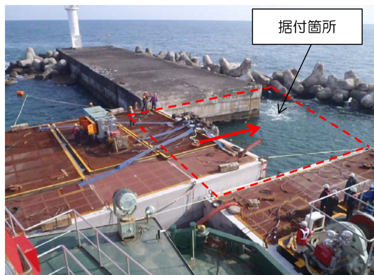
ケーソン据付状況
