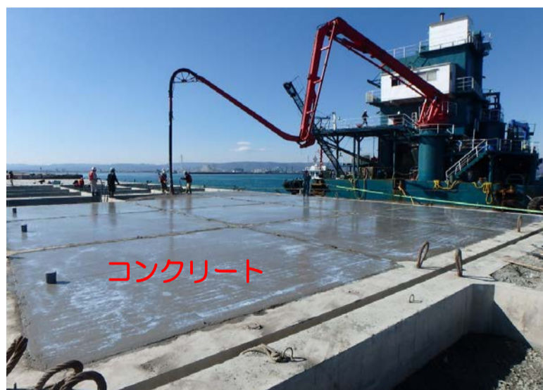
コンクリート打設状況
