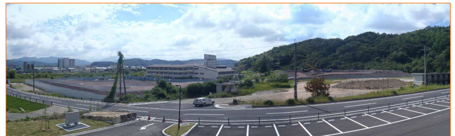
豊岡南高校跡地仮置場
