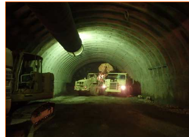
トンネル掘削状況
