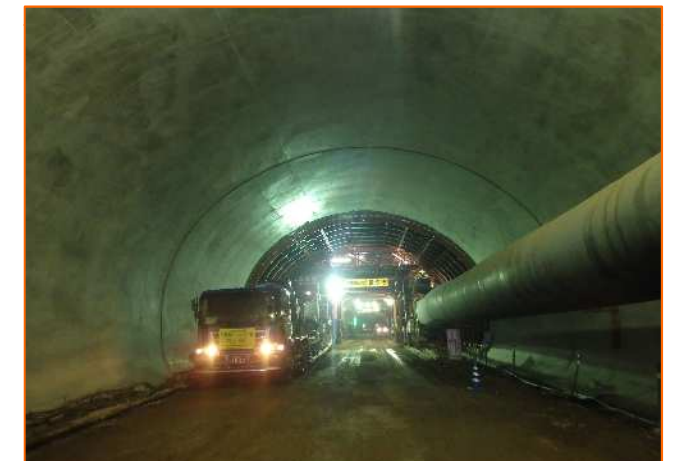
覆工施工状況
