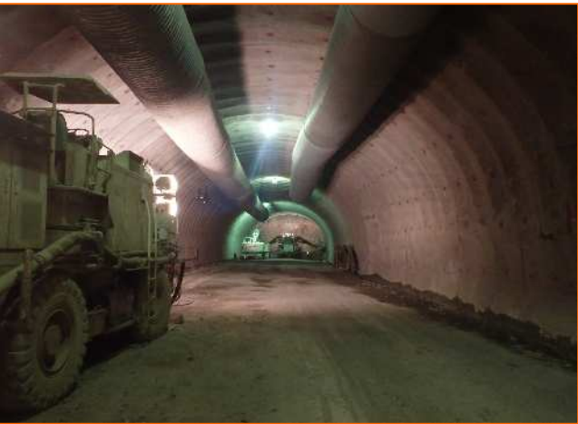
トンネル掘削状況
