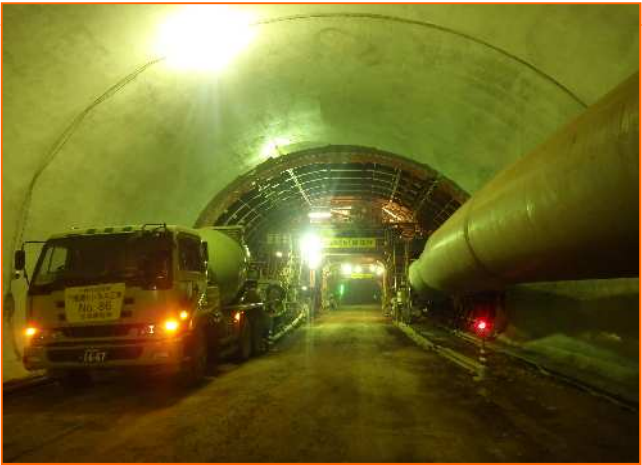
覆工施工状況
