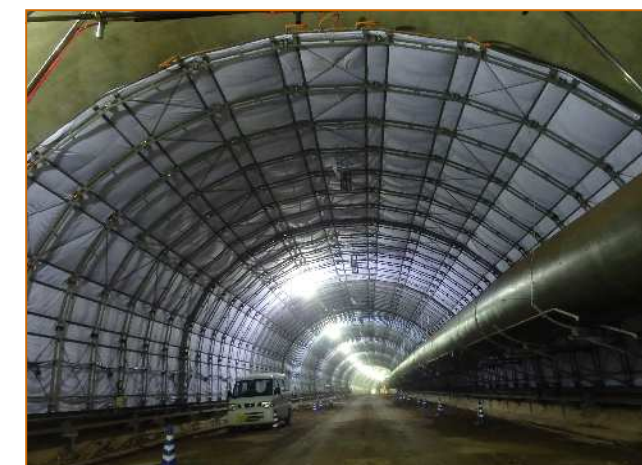
覆工養生状況
