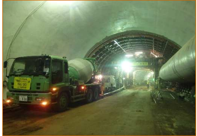
覆工施工状況
