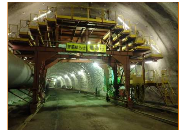
防水工施工状況
