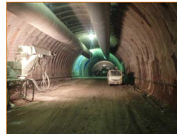
トンネル掘削状況
