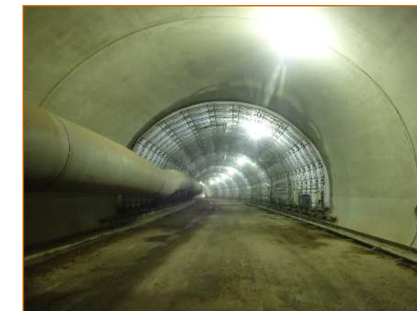
覆工完了区間
