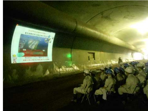
トンネル工事・土木工事について
