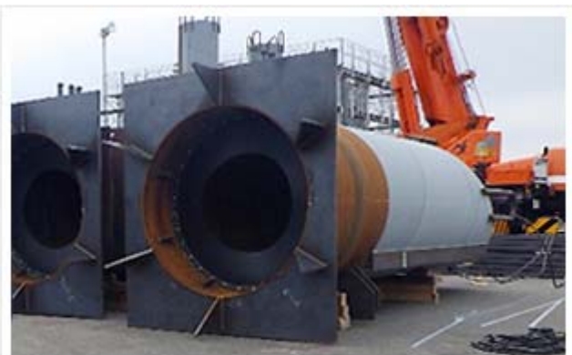
ガイド管底の据付誘導鋼製プレート
