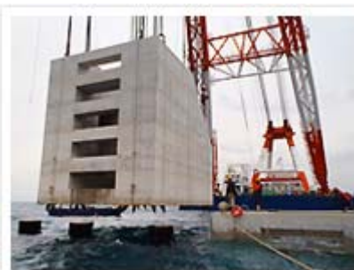
ガイド管底の据付誘導鋼製プレート
