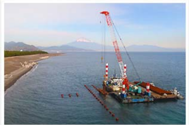
ハーフセップ台船による鋼管杭打設
