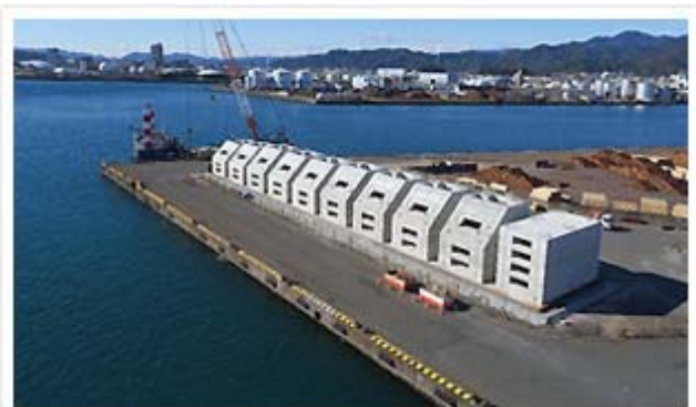
横堤9函と接続堤1函製作完了
