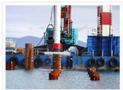
油圧ハンマによる支持層打込み
