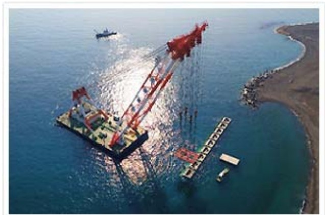
大型起重機船によるケーソン据付け
