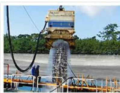
パイプロハンマとウォータージェットの併用
