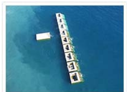
ケーソン据付け完了
