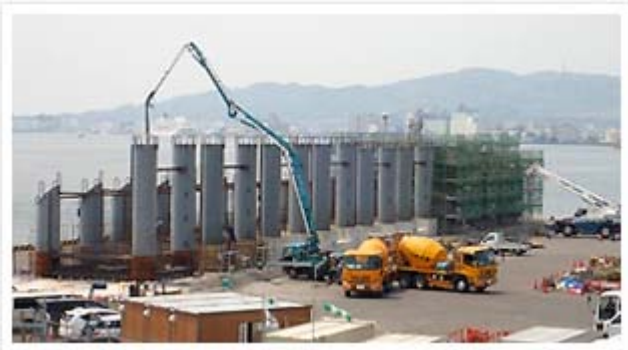
ケーソン製作全景
