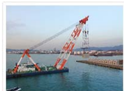
岸壁からのケーソン浜出し
