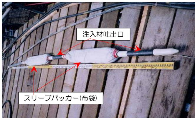
③ 順次ステップアップし、最後にマンシエツチューブから孔内にセメントベントナイトを充填する
