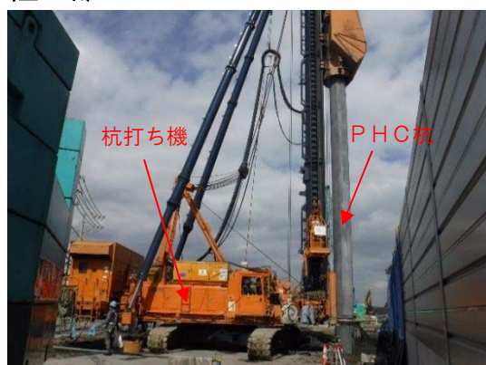
杭打ち機による打設状況
