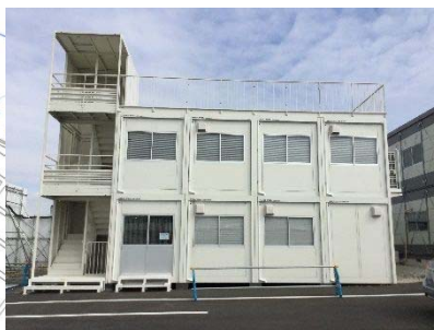
工事広報館全景
