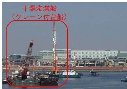
クレーン付台船による干潟表土の浚渫状況
