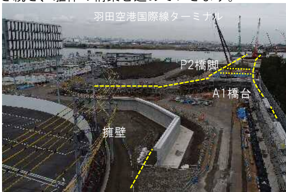
擁壁部（殿町側から羽田側を望む）
