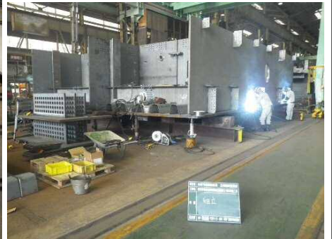
鋼桁組立状況
