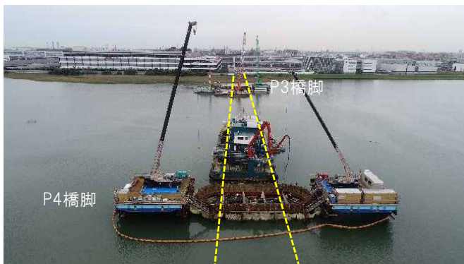
河川内作業状況（羽田側から殿町側を望む）
