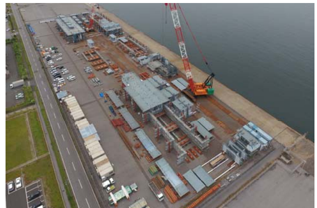
組立状況(富津市)
