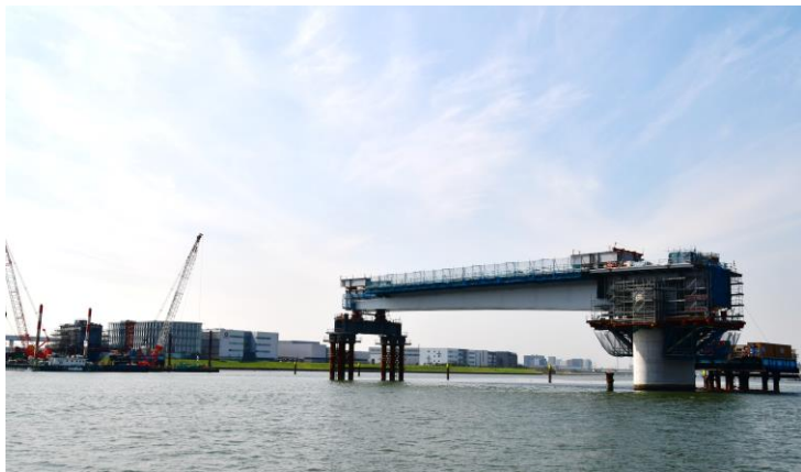
橋桁架設完了
