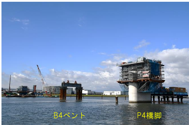
架設前（B4ベントーP4橋脚）全景
