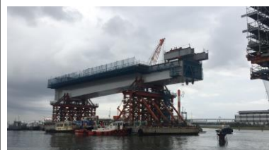
台船一括架設工法
