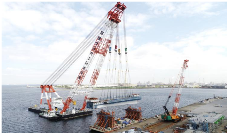
橋桁積込状況（千葉県富津市）
