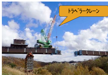
トラバークレーン架設工法
