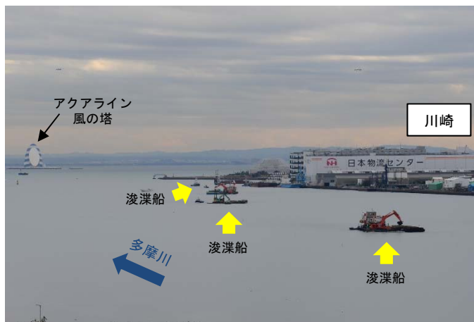
航路部浚渫状況
