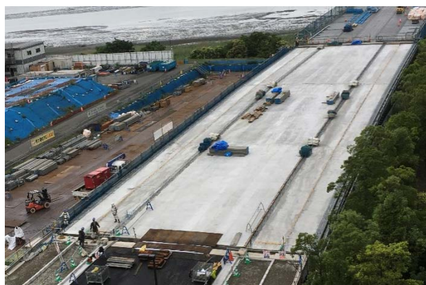
取付部施工状況(6月 床版コンクリート打設完了)
