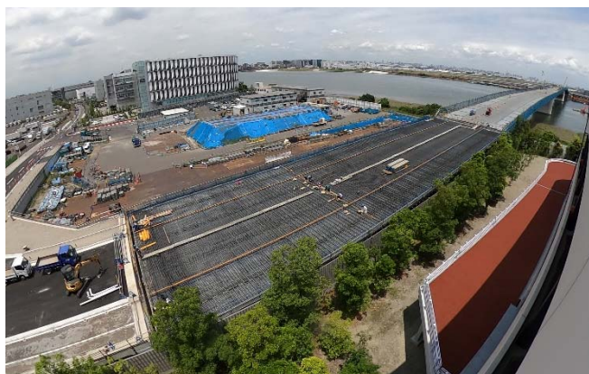
取付部施工状況(5月 床版の鋼板設置・鉄筋組立完了)
