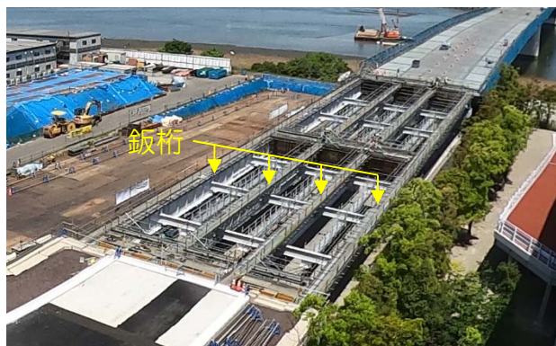
取付部施工状況(4月 鉄桁組立完了)
