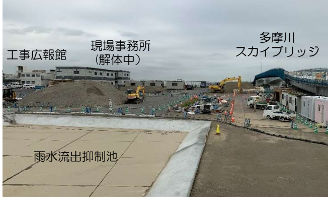
工事ヤード復旧工事状況
