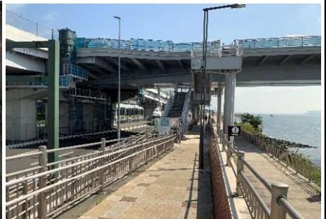
足場撤去完了 (多摩川上流より)
