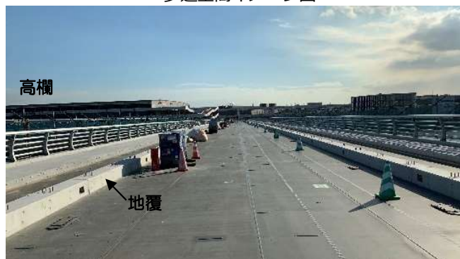
車道部（都県境から殿町側を望む）
