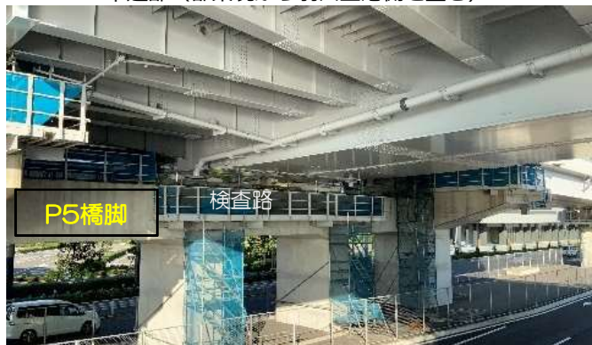
環状八号線橋脚の検査路設置状況
