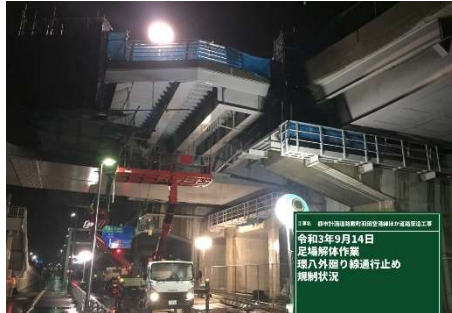
夜間足場撤去状況
