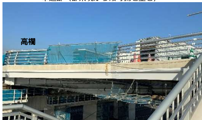
階段から見る高欄設置状況
