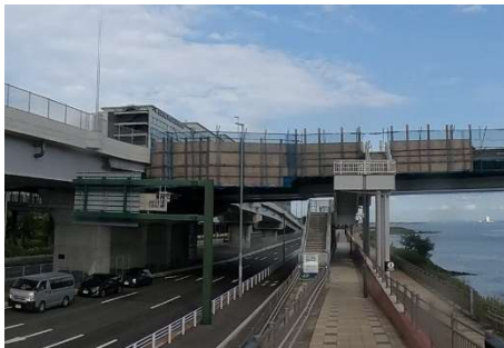
足場撤去前 (多摩川上流より)
