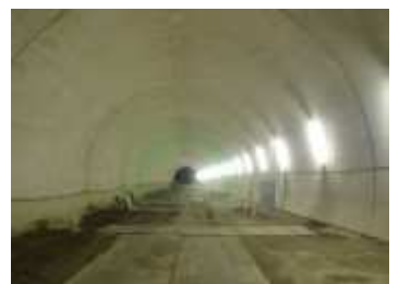
トンネル坑内の覆工完了区間
