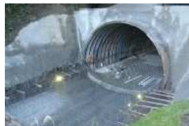
起点側坑門インバート鉄筋組立状況
