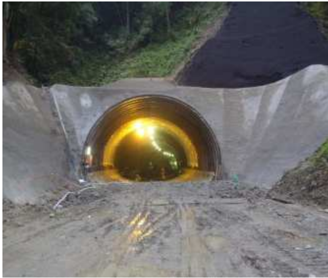
起点側貫通（トンネル掘削完了）
