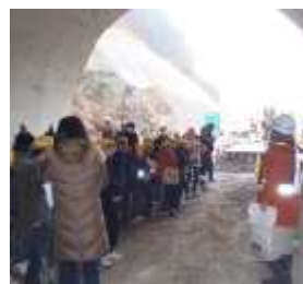
坑内での説明の様子
