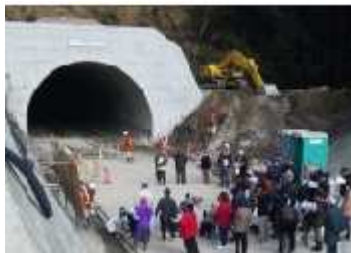
君津側坑口での説明の様子
