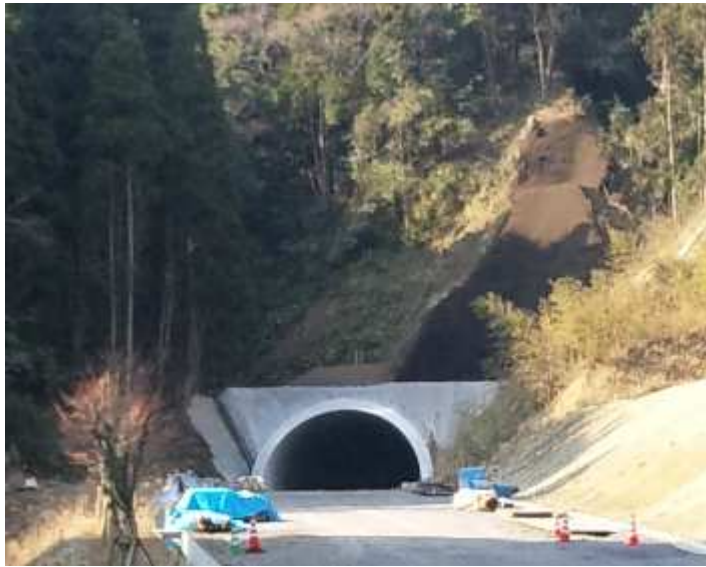
大多喜側坑門工完成
