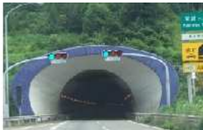
関越トンネル群馬側坑口
