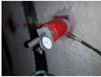
ロックボルト引抜き試験状況
