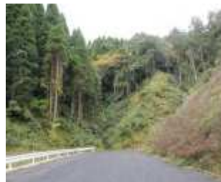
大多喜側着工前
