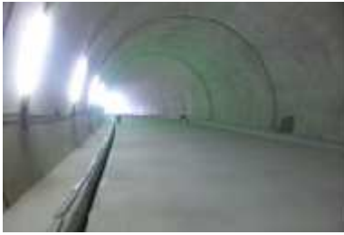
トンネル内より大多喜側
