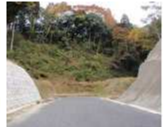
君津側着工前
