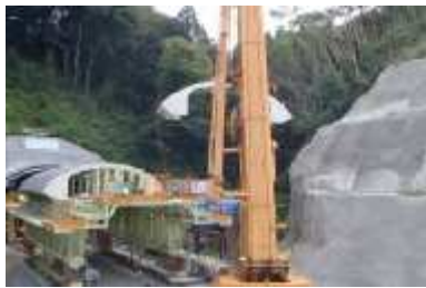
セントル組立状況
