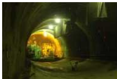
坑内カーブ状況
