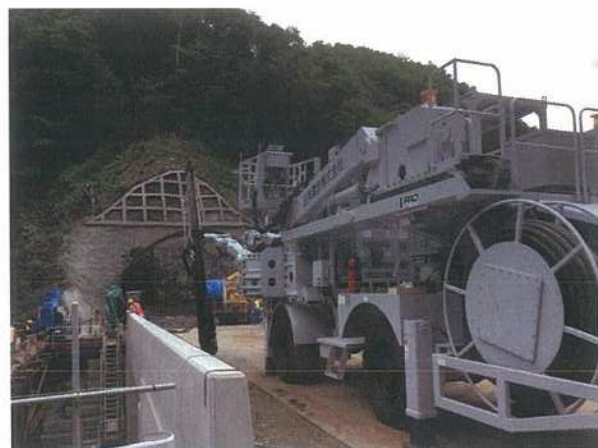
与部沢トンネル（仮称）終点側坑口
