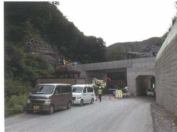
葛部沢橋（仮称）（上流側から）
